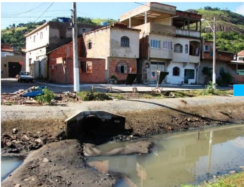
Lançamento de esgoto na rede pluvial
