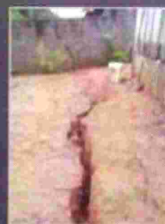
Trincas ou rachaduras no solo
