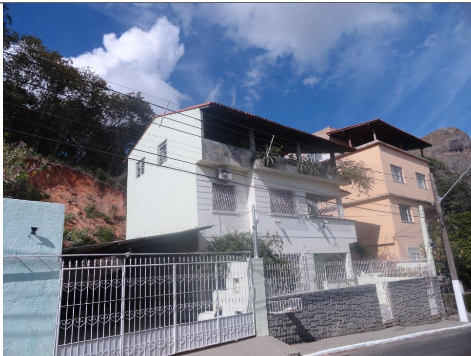
Figura 25 – Vista das moradias e grande erosão nos fundos das mesmas.
