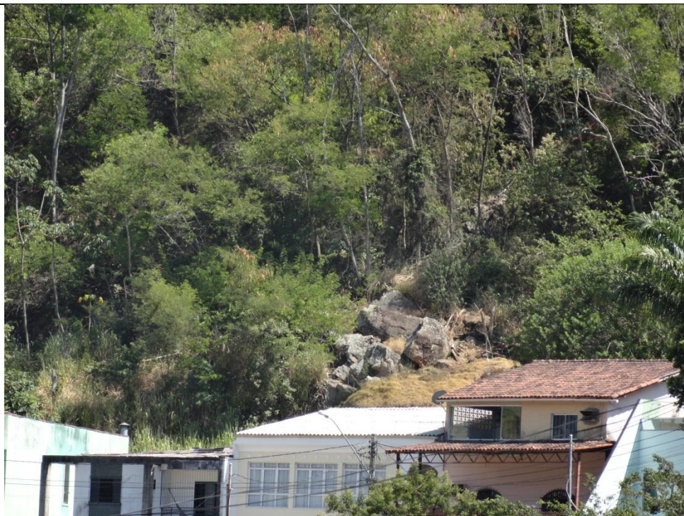
Figura 23 – Vista parcial do setor com lascas, blocos e matacões instáveis nos fundos das moradias.
