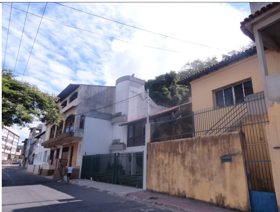
Figura 28 – Vista das moradias que compõem o setor de risco.
