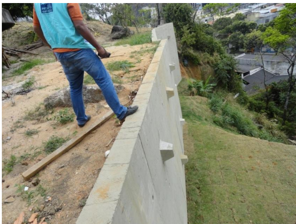
Figura 20 – Obra de contenção realizada em parte do talude, eliminando risco desta parte da área.
