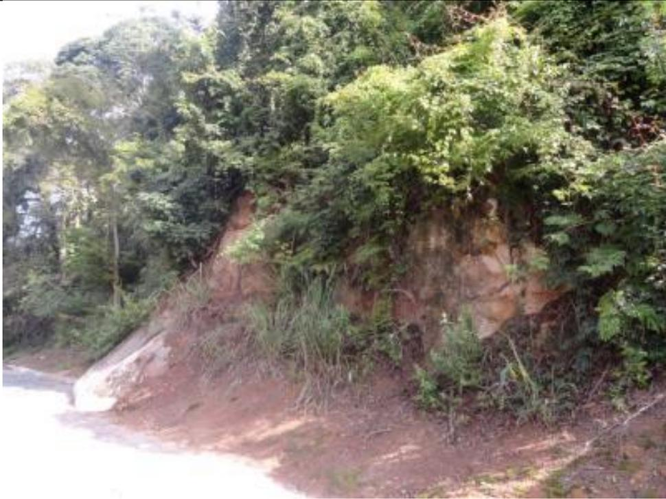
Figura 59 - Parte do talude em processo erosivo, com risco de obstruir rua que dá acesso a escola.
