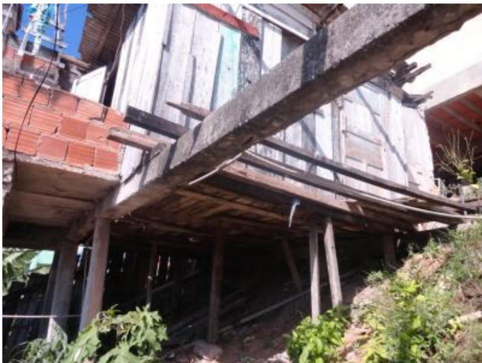
Figura 78 - Moradia de madeirite com sérios problemas estruturais que deverá ser removida da área.
