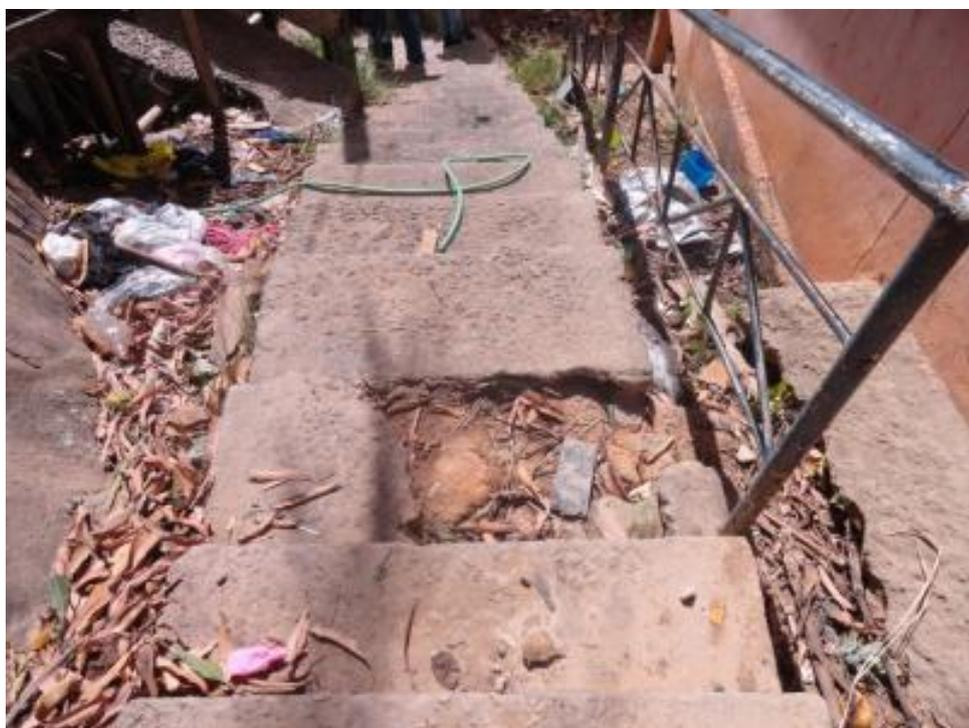
Figura 93 - Escadaria danificada e sem sistema de drenagem.
