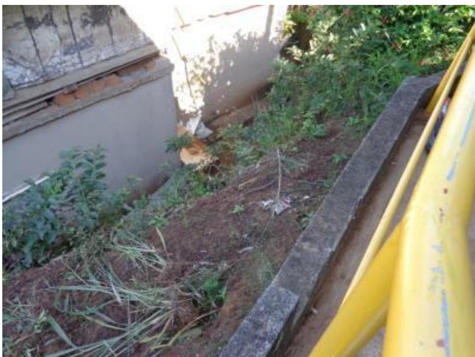
Figura 40 - Talude na base da escadaria e bem próximo à moradia com processos erosivos.
