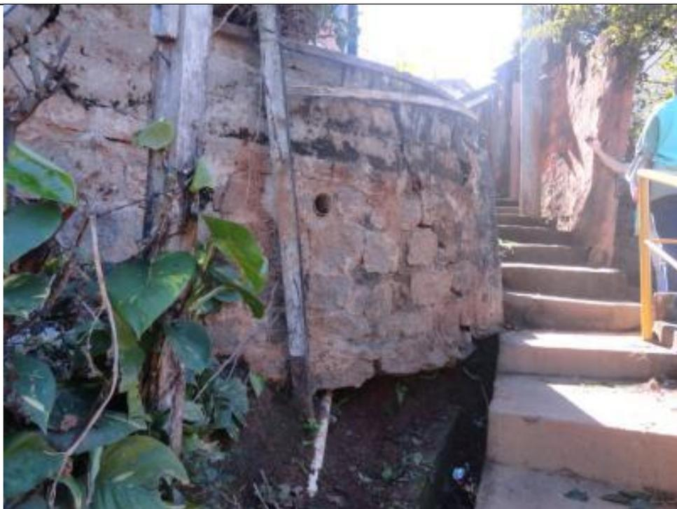
Figura 43 - Muro de pedras com problemas estruturais.
