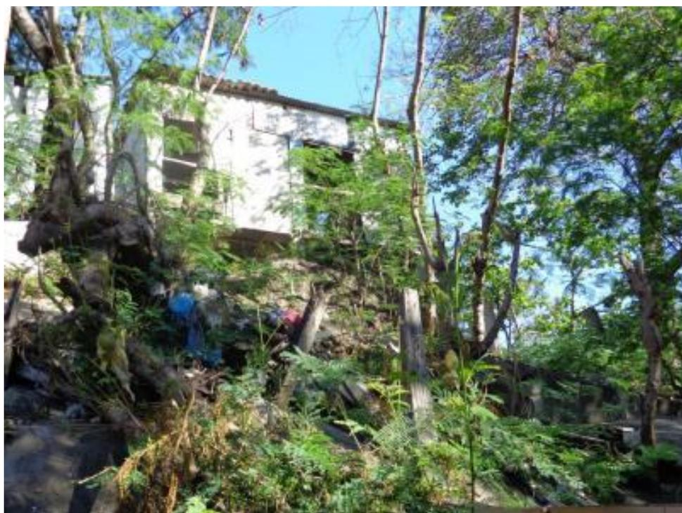
Figura 110 - Presença de muito lixo/entulho e moradia sendo construída na crista do talude.
