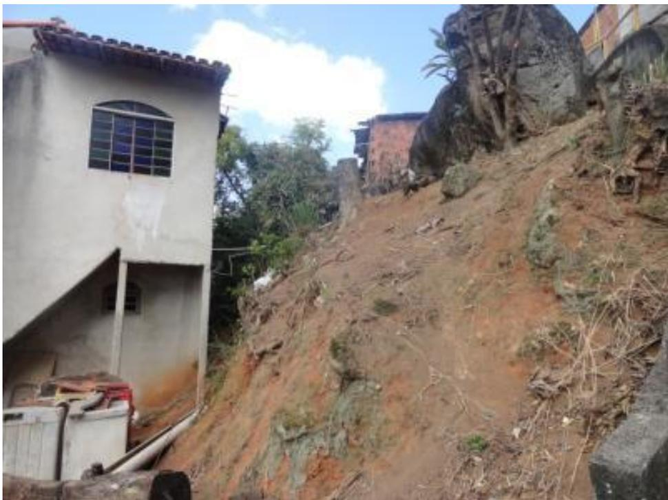
Figura 67 - Vista lateral do talude com blocos instáveis na crista.
