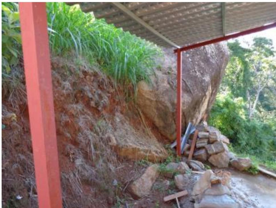
Figura 36 - Bloco de rocha de grande porte com erosão na base.
