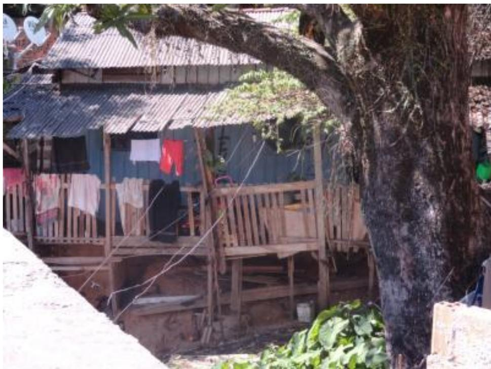
Figura 82 - Moradia de madeira com risco estrutural, que deverá ser removida.
