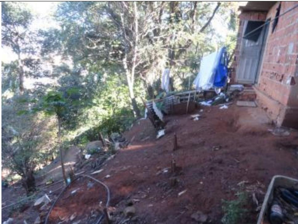
Figura 41 - Árvores inclinadas e feições erosivas muito próximas à moradia.
