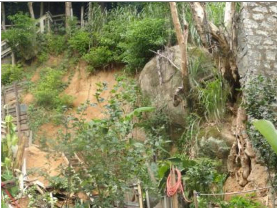
Figura 54 - Blocos instáveis próximos a cicatriz de escorregamento. Notar erosão entre blocos e muro de pedras, agravando o risco para a área.
