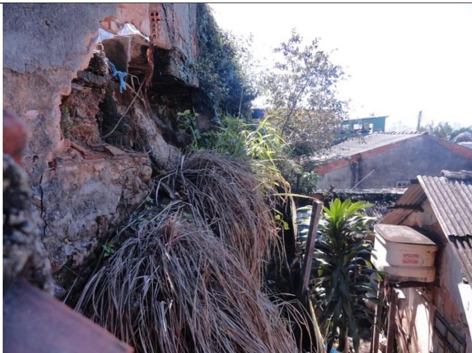
Figura 103 – Erosão em talude abaixo de acesso a moradia a montante, deixando a moradia à jusante em risco.
