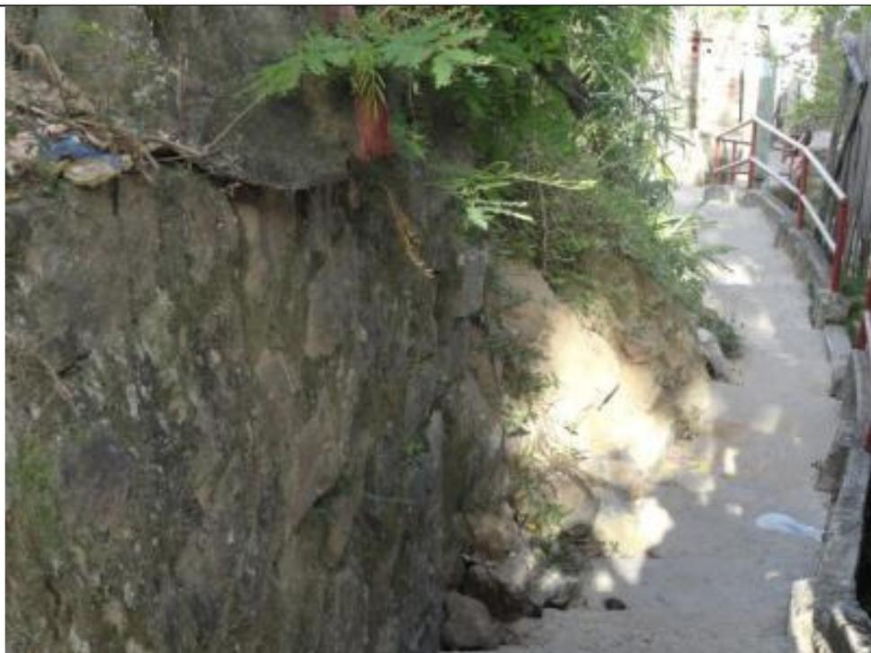
Figura 98 - Muro de pedras rompido, deixando parte da Escadaria Ana Ferreira de Oliveira obstruída.
