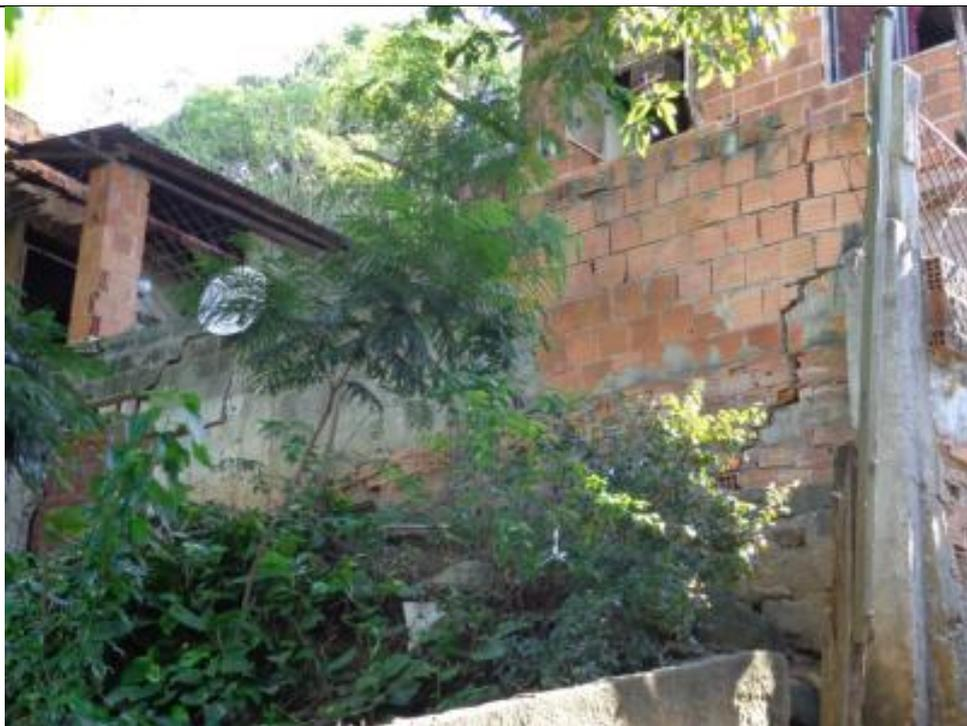
Figura 39 - Muro com problemas estruturais localizado no meio do talude.
