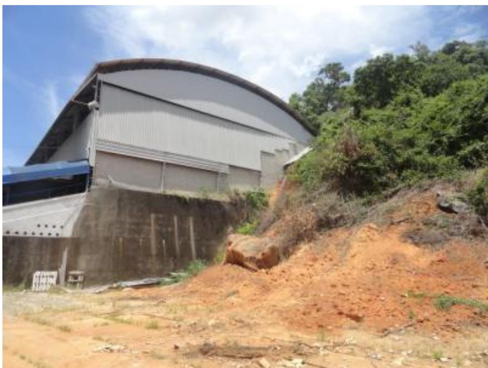
Figura 128 - Deslizamento de terra com queda de bloco ao lado da edificação.
