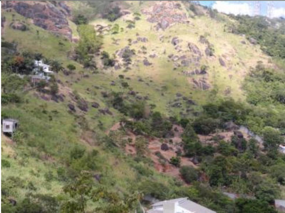
Figura 123 - Diversos blocos e matacões dispersos no talude nos fundos das moradias.
