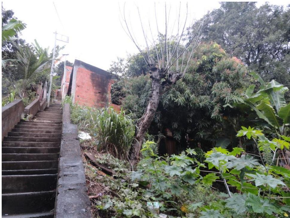
Figura 144 – Escadaria de acesso ao setor, sem sistema de drenagem.
