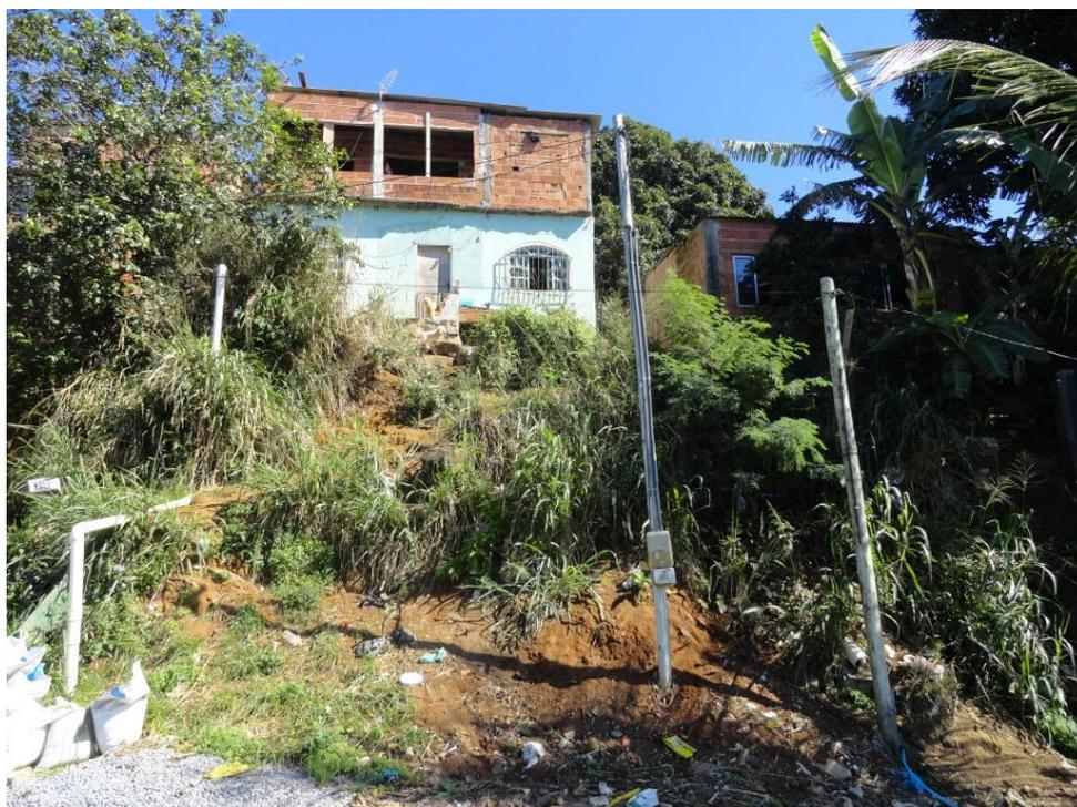
Figura 60 – Feições erosivas no talude.
