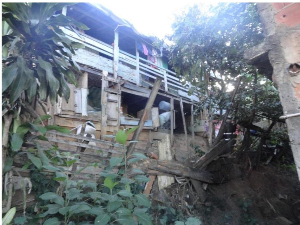
Figura 146 – Moradia de baixo padrão construtivo em talude com feições erosivas.
