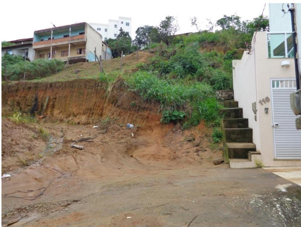
Figura 160 – Realização de cortes sem orientação, causando instabilidade no talude.
