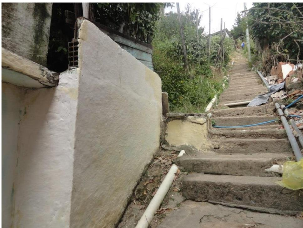
Figura 154 – Escadaria de acesso ao setor, sem sistema de drenagem.
