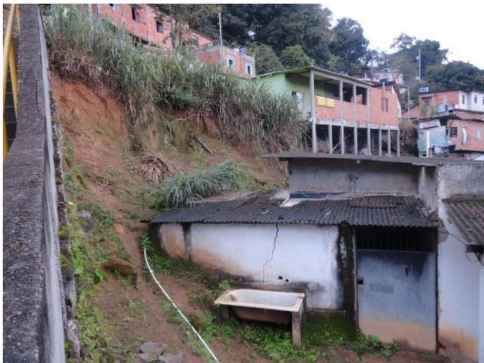
Figura 63 – Cicatriz de escorregamento no talude e na base da escada.
