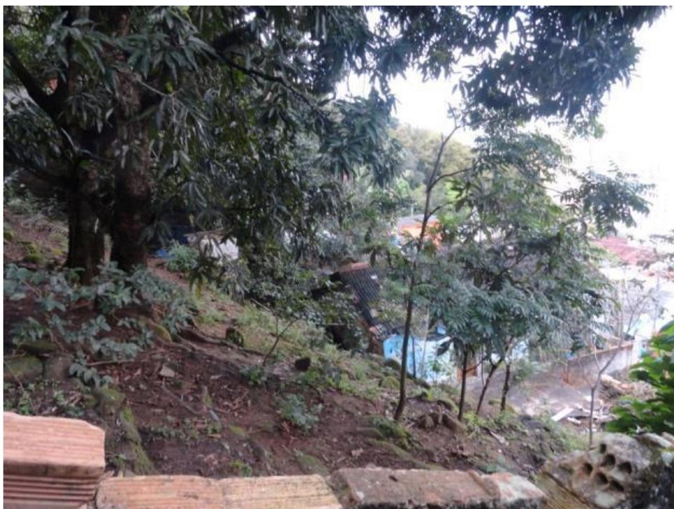
Figura 81 – Vista de talude com corte irregular em sua base para implantação de moradia.
