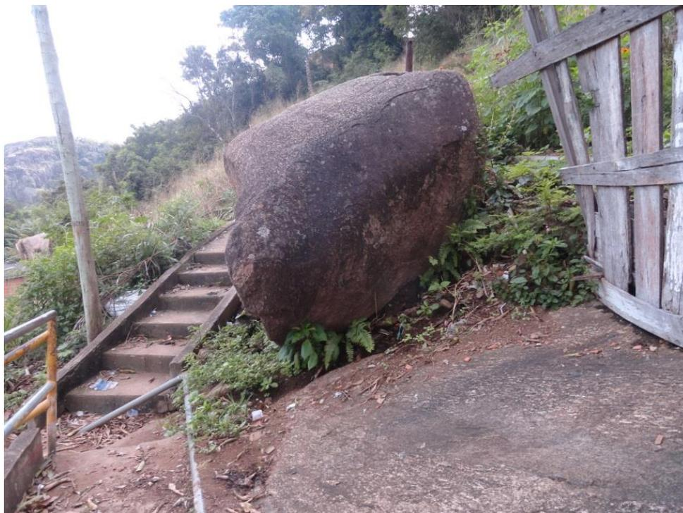
Figura 100 – Bloco instável no topo da escadaria.
