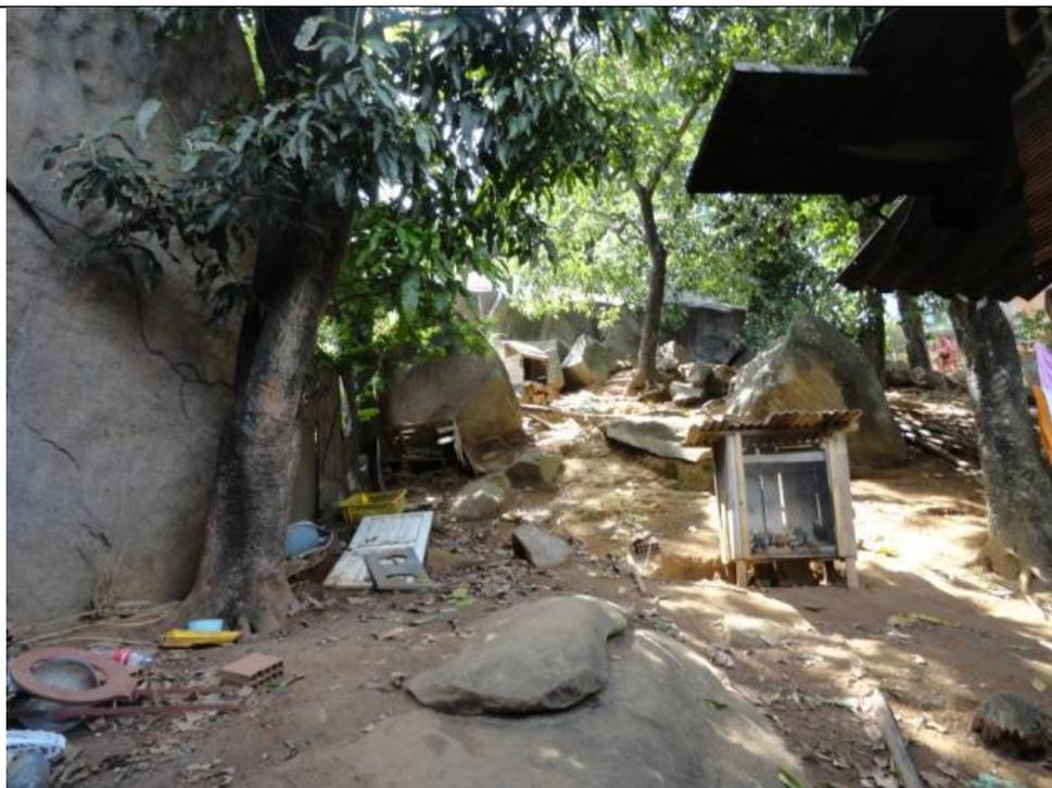
Figura 4 – Diversos blocos e lascas dispersos no talude, proveniente de desmontes irregulares.
