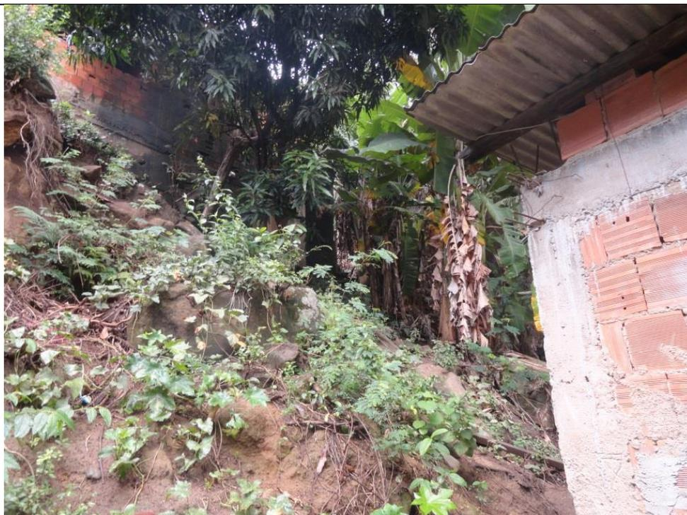
Figura 145 – Processo erosivo no talude entre as moradias.
