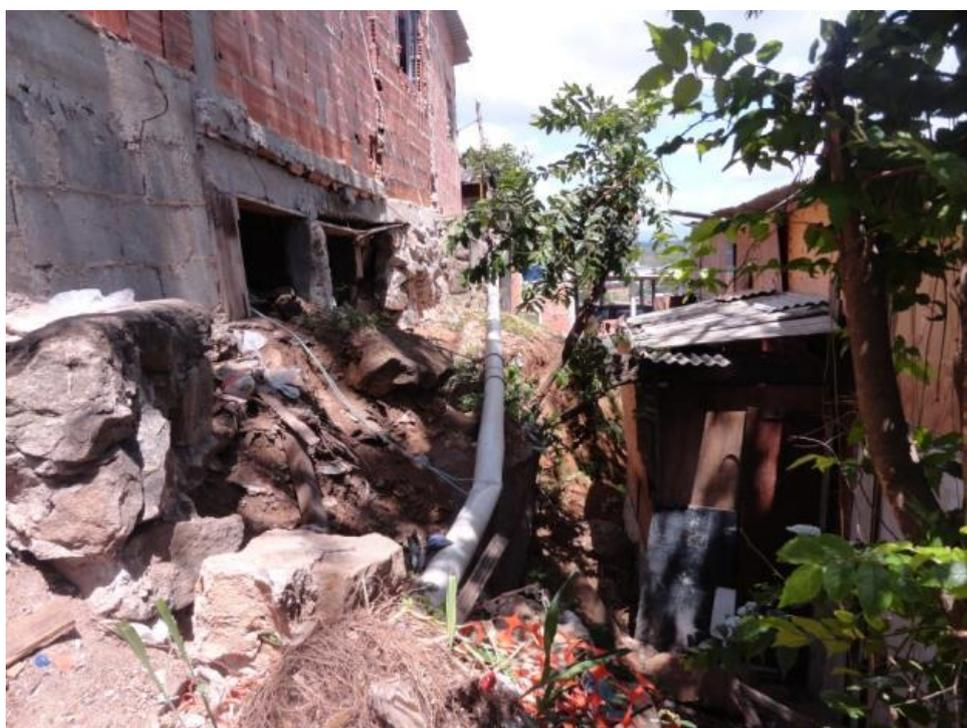
Figura 31 – Erosão no talude entre moradias.
