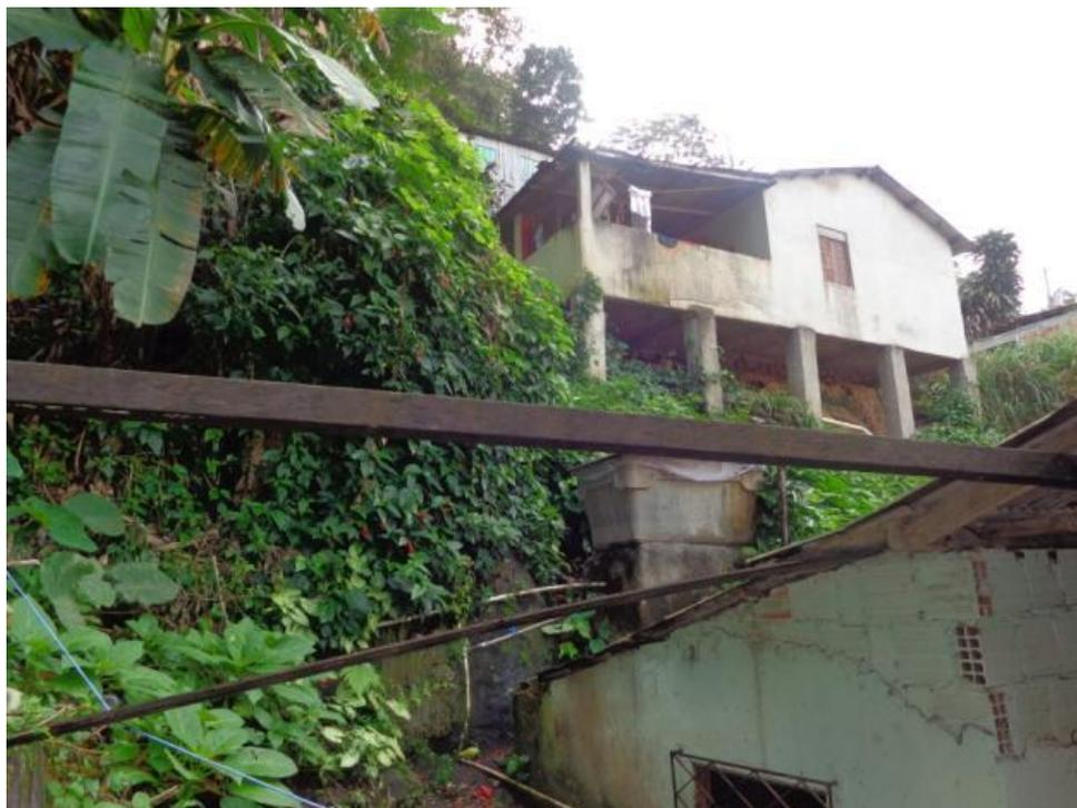
Figura 76 – Processo erosivo no talude entre as moradias, afetando a fundação da moradia no topo.
