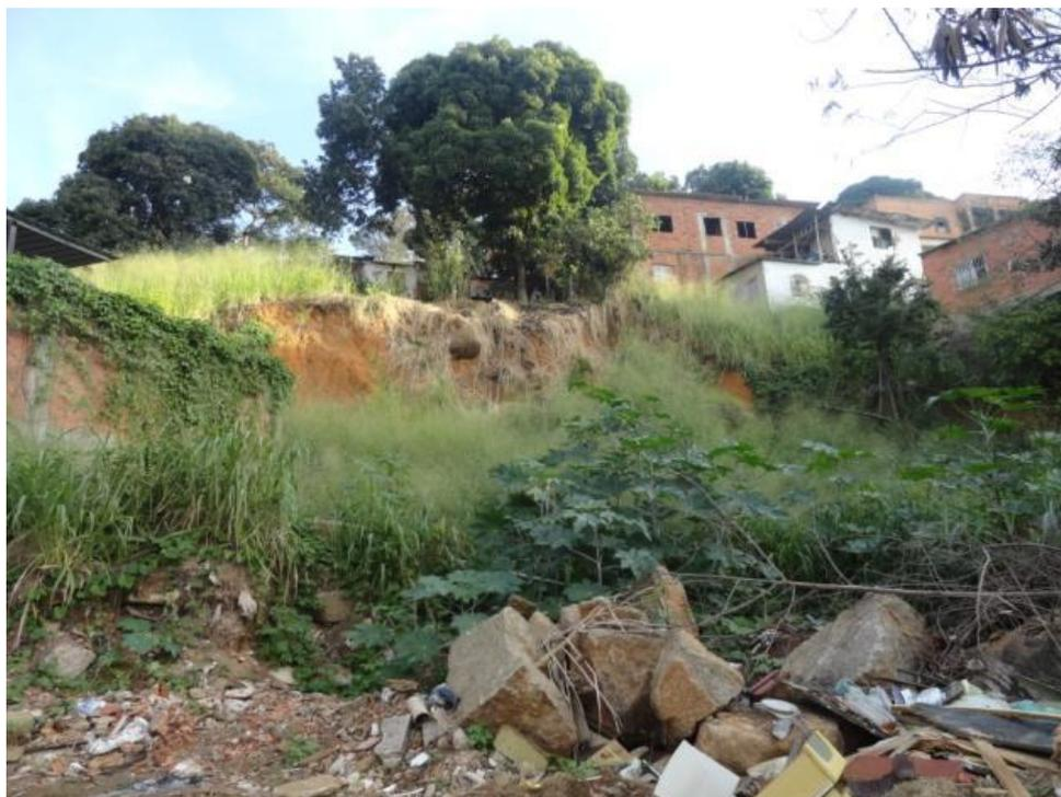
Figura 7 – Vista geral do setor com cicatriz de escorregamento e blocos instáveis na crista do talude, além de muito lixo/entulho na base, próximo a Rodovia Serafim Derenze.
