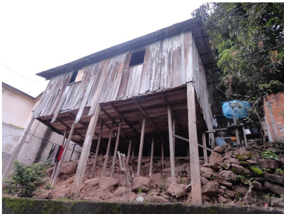
Figura 152 – Moradia de muito baixo padrão construtivo em linha de drenagem natural.
