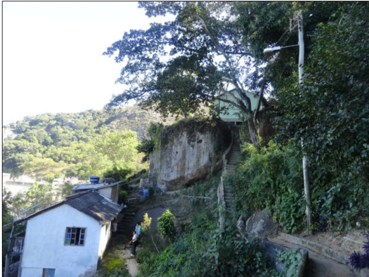
Parte da moradias presentes no Setor 4 – R3 – Bairro Forte São João
