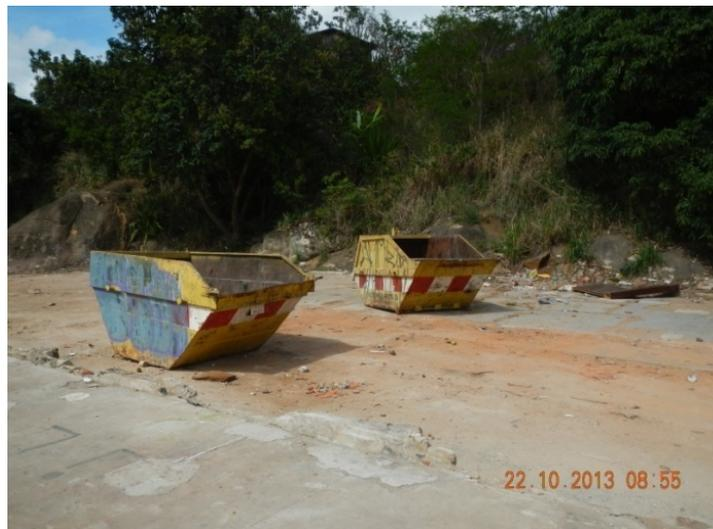
**Figura 7:** Caçambas estacionárias para resíduos da construção civil.
