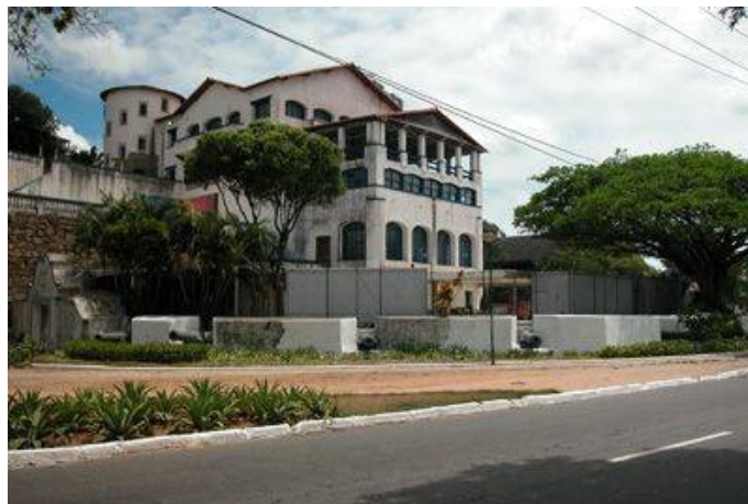
Figura 21: Forte São João.
