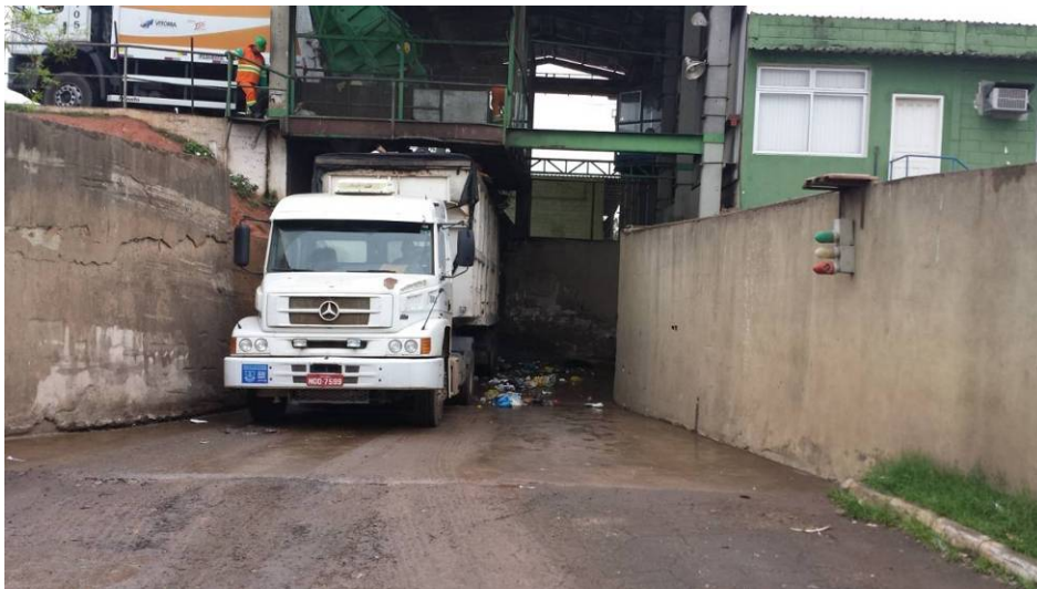
Figura 11: Transbordo de RSU de caminhão compactador para carreta.
