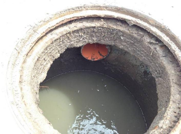
**Figura 48:** Identificação de ligação clandestina de esgoto na rede de drenagem da Rua Francisco Santos.
