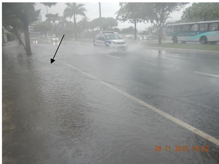
**Figura 30:** Ponto de Alagamento - águas de chuva ultrapassando o nível da calçada – Av. Mascarenhas de Moraes.
