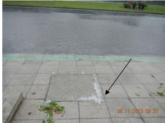
**Figura 13:** Água de chuva retornando nas caixas instaladas na calçada.
