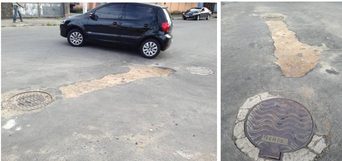
**Figura 47:** Identificação de ligações clandestinas de esgoto na rede de drenagem da Rua Belmiro Teixeira Pimenta.
