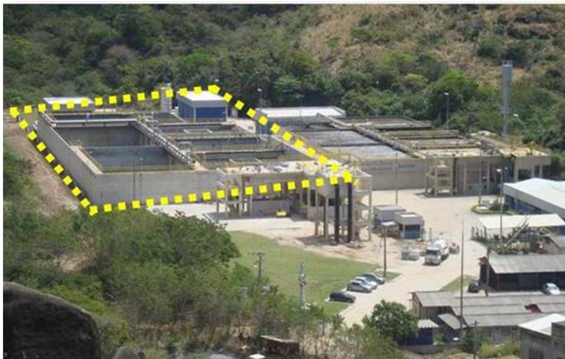
Figura 31: Estação de tratamento de esgoto Mulembá.
