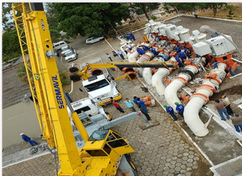
Figura 13: Estação Elevatória Alto Recalque – EEAR (Sistema Jucu) – Instalação de válvulas de retenção e ventosas.
