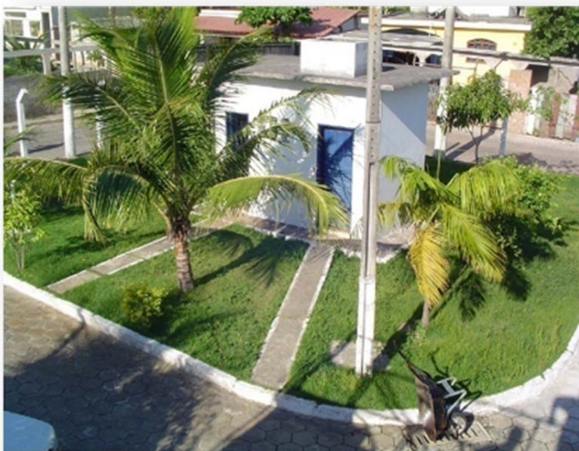
Figura 34: Estação elevatória de esgoto bruto do SES Grande Vitória. Trocar foto
