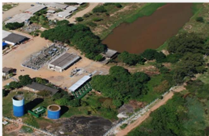
Figura 12: Vista da captação do Rio Jucu e do Baixo Recalque.
