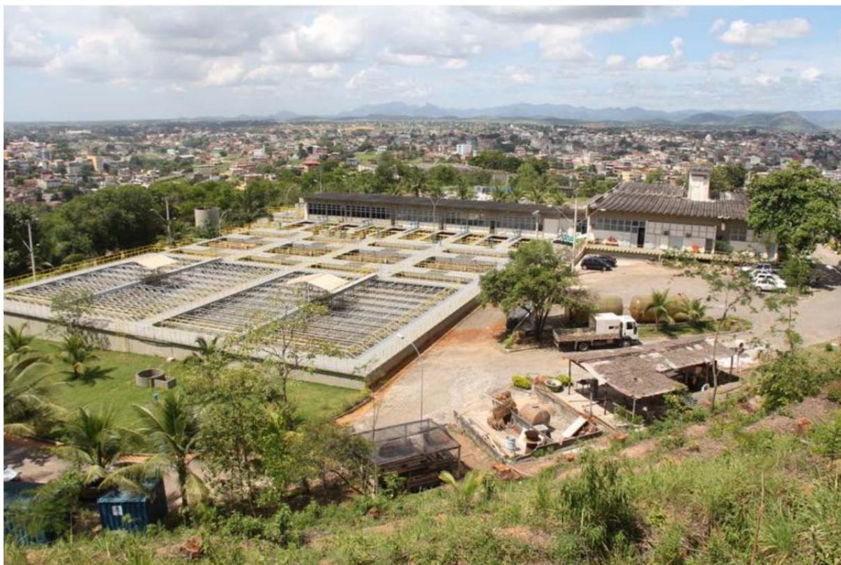
Figura 14: Estação de Tratamento de Água de Vale Esperança – ETA 1.
