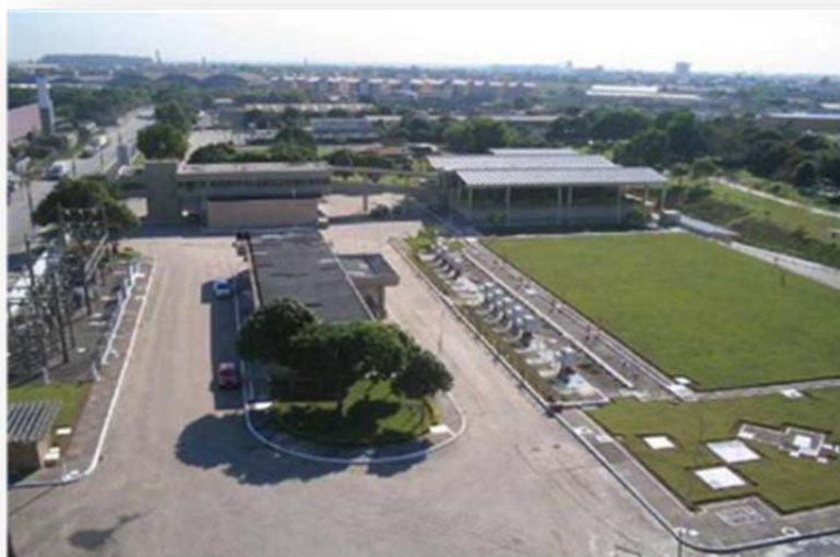
Figura 21: Estação de Tratamento de Água – ETA V.
