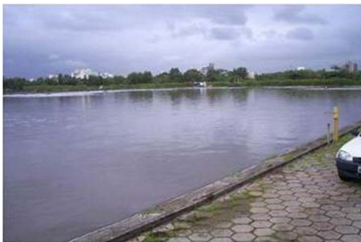
Figura 30: Estação de tratamento de esgoto Camburi.
