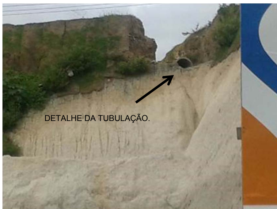
Figura 45: Detalhe da tubulação.
