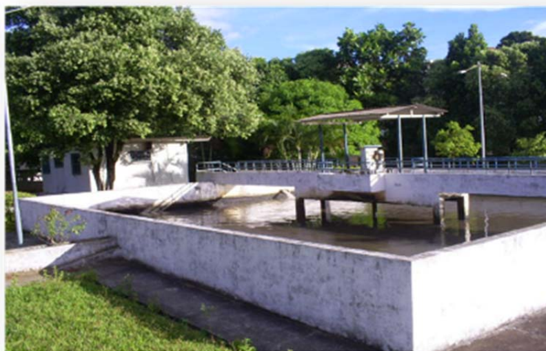
Figura 33: Estação de tratamento de esgoto Santa Tereza.
