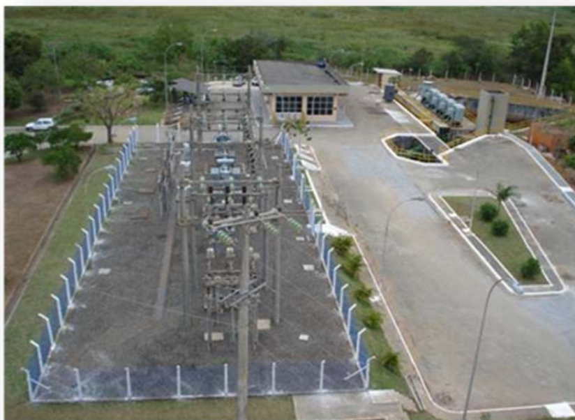
Figura 20: Captação do subsistema Carapina.
