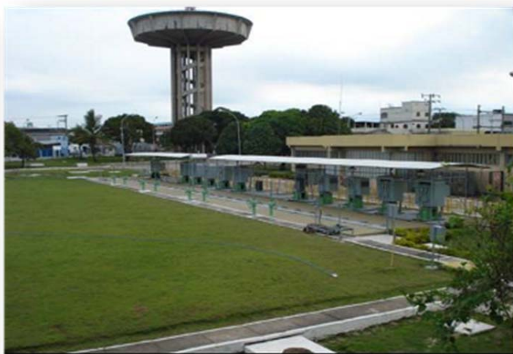
Figura 22: Elevatória e Recalque de Água Tratada Planalto.
